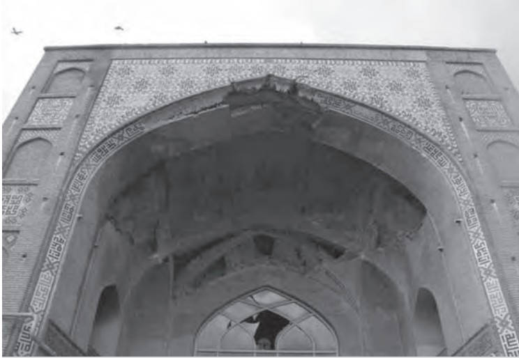
نمونه‌ای از خسارات وارد شده به نازک‌کاری‌ها و نما در زلزله ۱۳۸۵ لرستان
