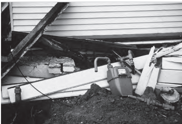
نمونه‌ای از خسارات وارد شده به لوله گاز در زلزله
